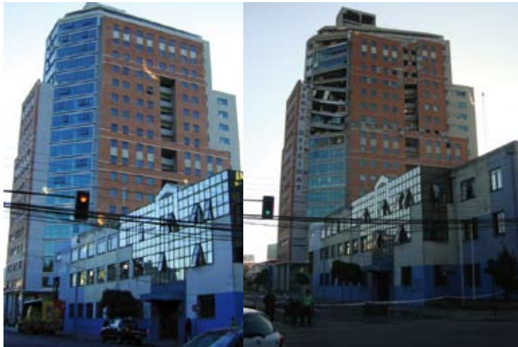
Antes y después de la Torre O'Higgins: Torre de oficinas de 22 niveles cuyo piso 12 falló, aparentemente a causa de la demolición de un eje estructural de muros, por parte de los responsables de las oficinas ubicadas en dicho nivel. CORTESÍA DPAE
