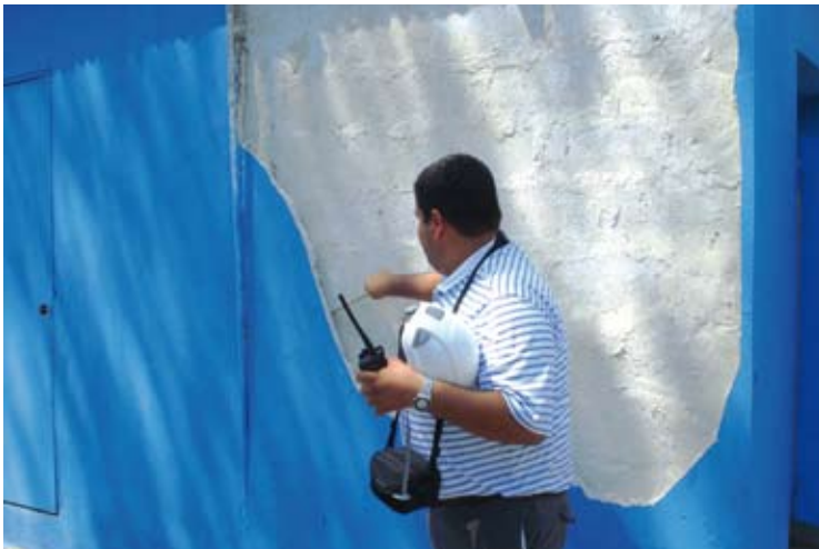
Retiro controlado de pañete en muros de cerramiento perimetral de la Comisaría de de Cabaret. CORTESÍA DPAE
